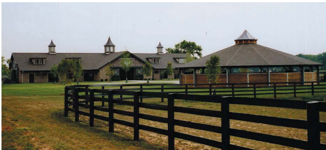
WINSTAR-Farm, Lexington, Kentucky (USA), Decken-Führanlage rund mit Bitumenschindeln
