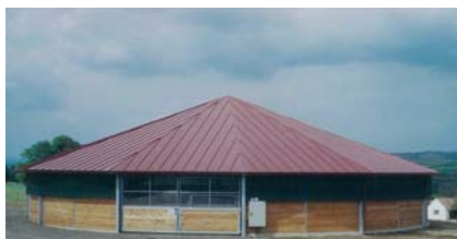
Spanische Hofreitschule, Wien, (A), Decken-Führanlage rund mit Falsblech und Windnetzen
