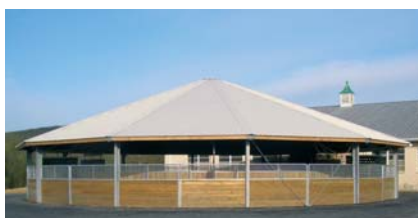
Darley und Kim Steward, Jefferson, Maryland (USA), Decken-Führanlage rund mit Trapezblech
