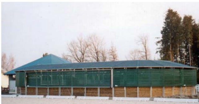
Giostra a scorrimento, Ovale 12 x 25 m (40' x 82') per 9 cavalli con tetto parziale. Scuderie a Buchenwald, Amtzell, Germania
