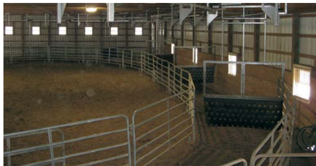
Giostra a scorrimento, Ovale 15 x 30 m, (50' x 99') per 12 cavalli installata in una struttura esistente. Stalle Bookmann, Acron, Ohio USA
